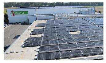
Durch Photovoltaik-Anlagen wird an beiden Standorten bereits Strom gewonnen. In Büttelborn wird dieser zur Deckung des eigenen Strombedarfs genutzt. Durch die Anlagen werden im Jahr 1.100.000 kWh Strom generiert. Mithilfe dieser Eigenproduktion können etwa 40% des Verbrauchs gedeckt werden, wodurch ein Ausstoß
